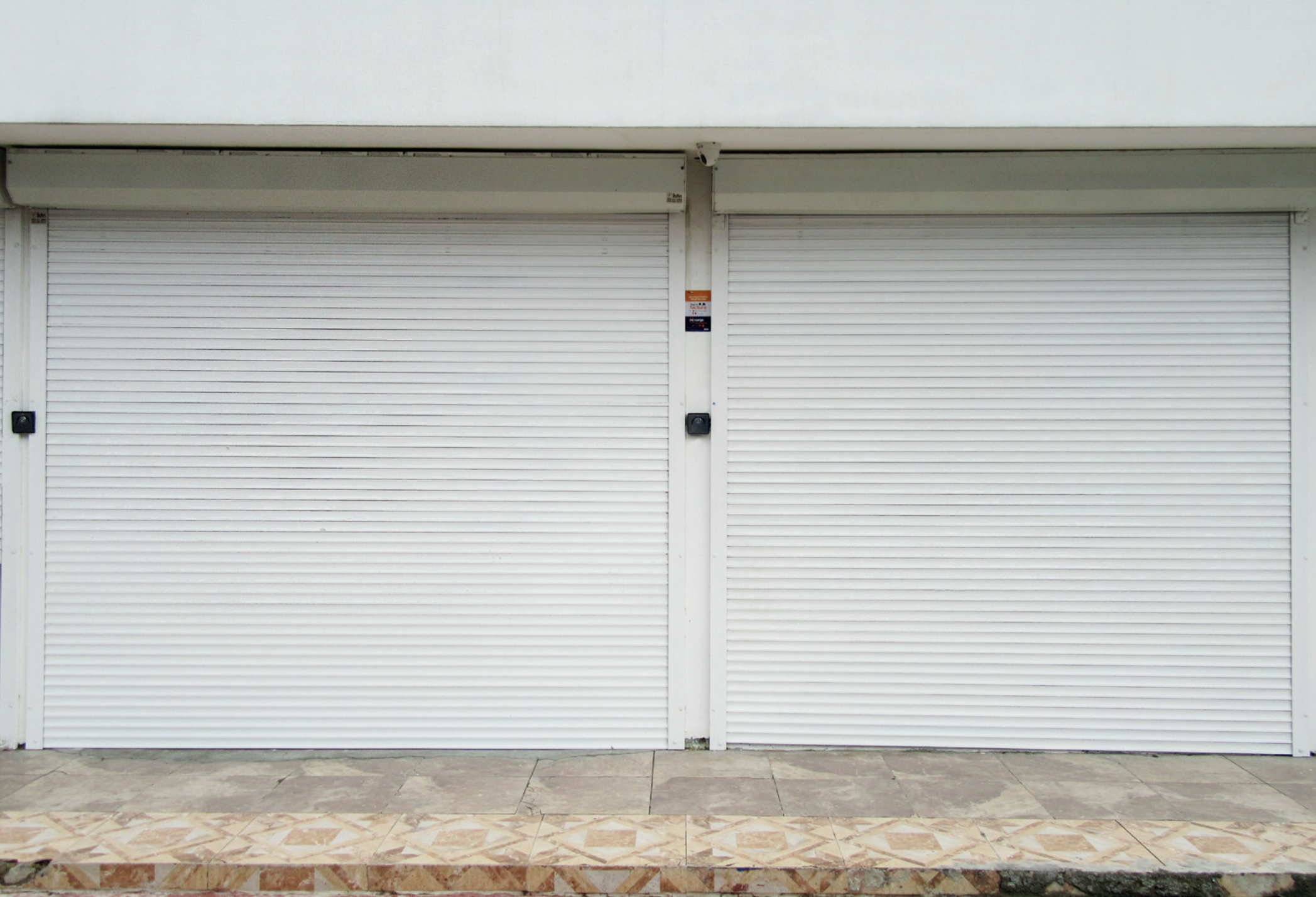
Shutter de 7.7 m2 - Lámina extruida blanca de 60mm - Sistema eléctrico con mando a distancia
